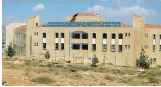
تسخين الماء بالطاقة الشمسية (4000 لتر) في مستشفى الهرمل الحكومي
